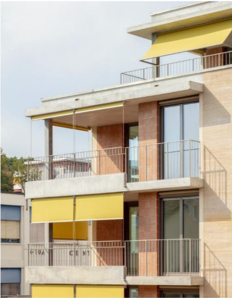
Durch das Ummanteln der Fassade mit Hanfkalk konnten Schichten reduziert werden. Bild: Paola Corsini
