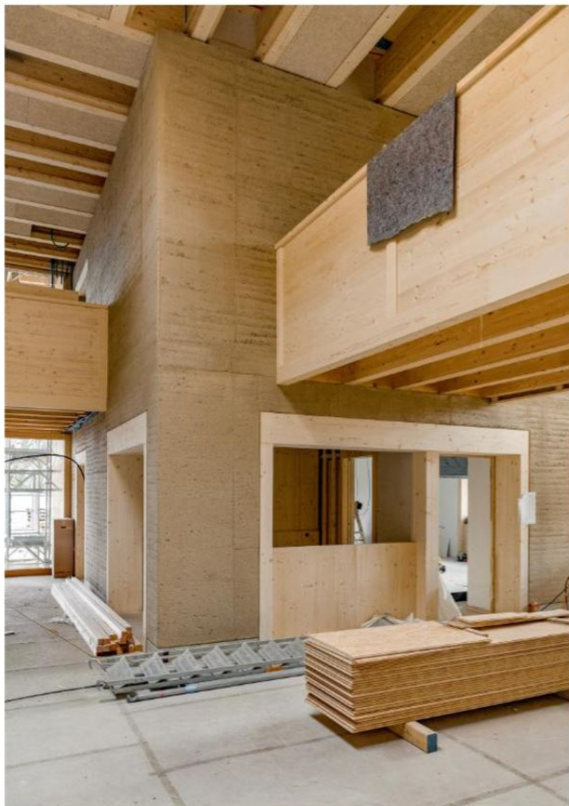
Ein doppelgeschossiger «espace interstitiel» mit Galerien verbindet die vier Bereiche des Quartierzentrums.
