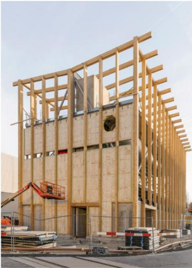
Ein Vierendeel-Stahlträger befreit die Technikzentrale darunter von allen Stützen. Die Fassade besteht aus Holz und Recyclingziegeln.
