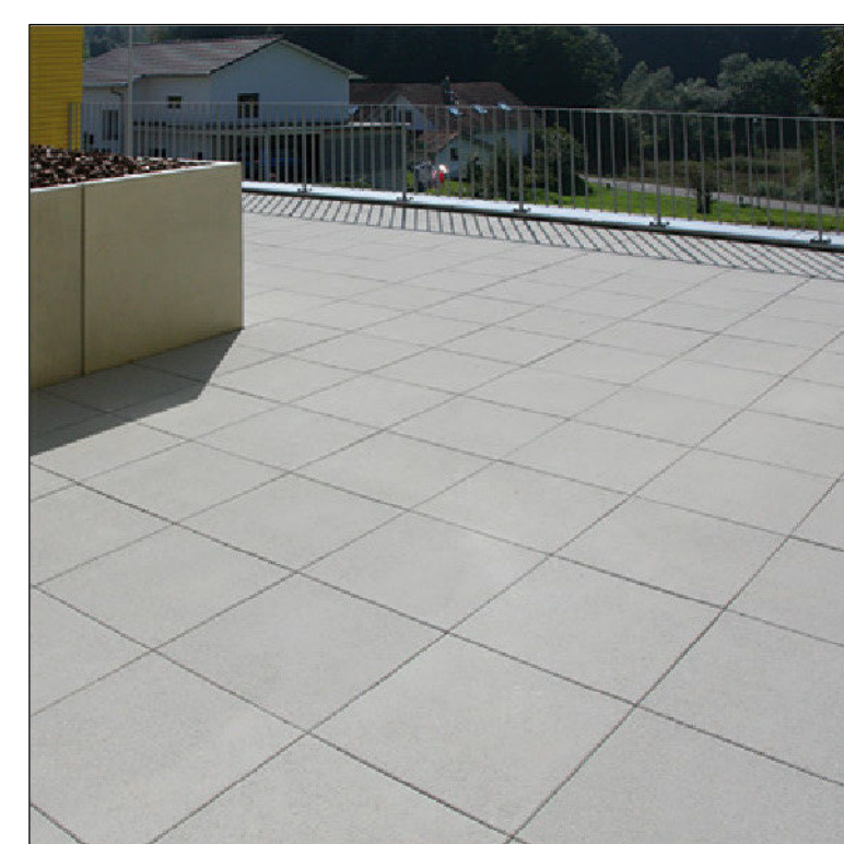
DETTAGLIO 2 Lastre in beton Creabeton DALLFORTE cod. K 00 10 grigie, lisce, smussate, dim. cm 50x50, KE 22
