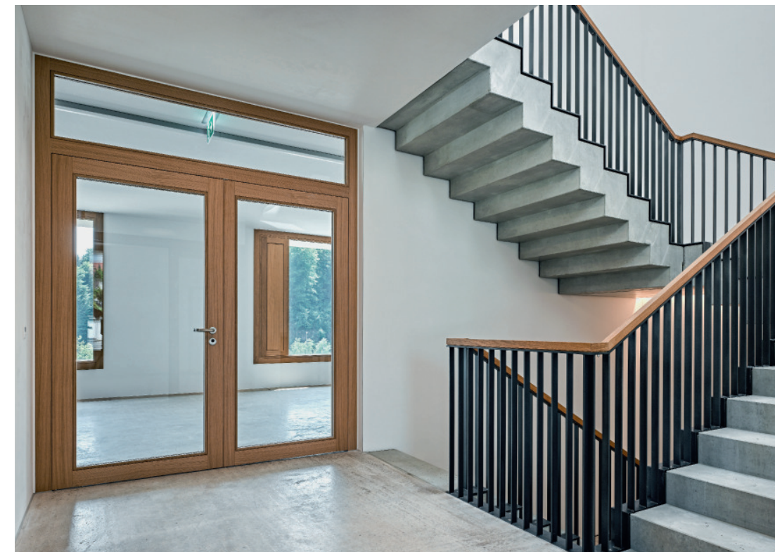
Treppenhaus aus rohem Beton mit einem Geländer aus Stahl und einem Handlauf aus Eichenholz
