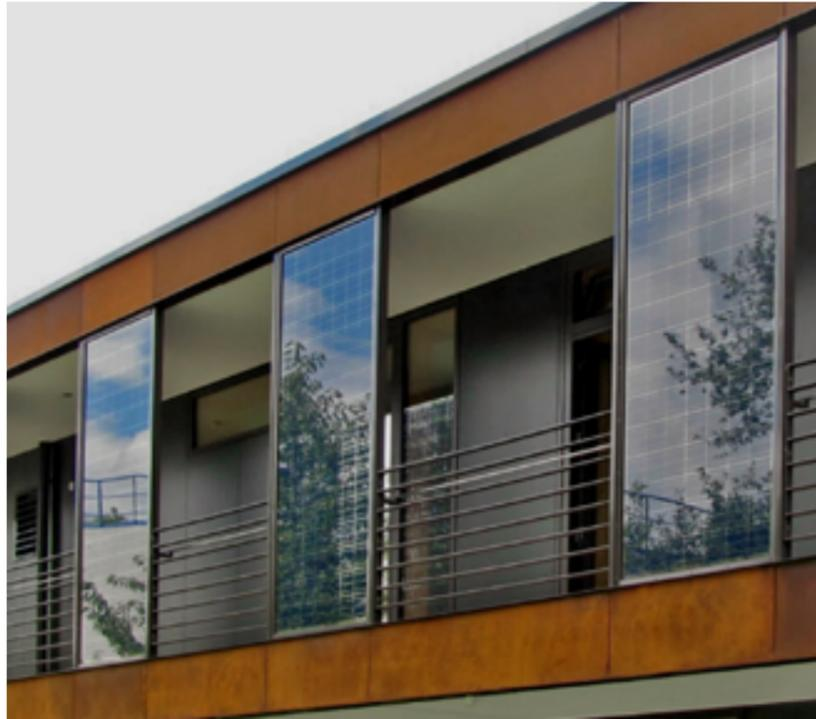
Beispiel für lichtdurchlässige photovoltaische Paneele - Ref. BIPVFassaden ERTEX.com
