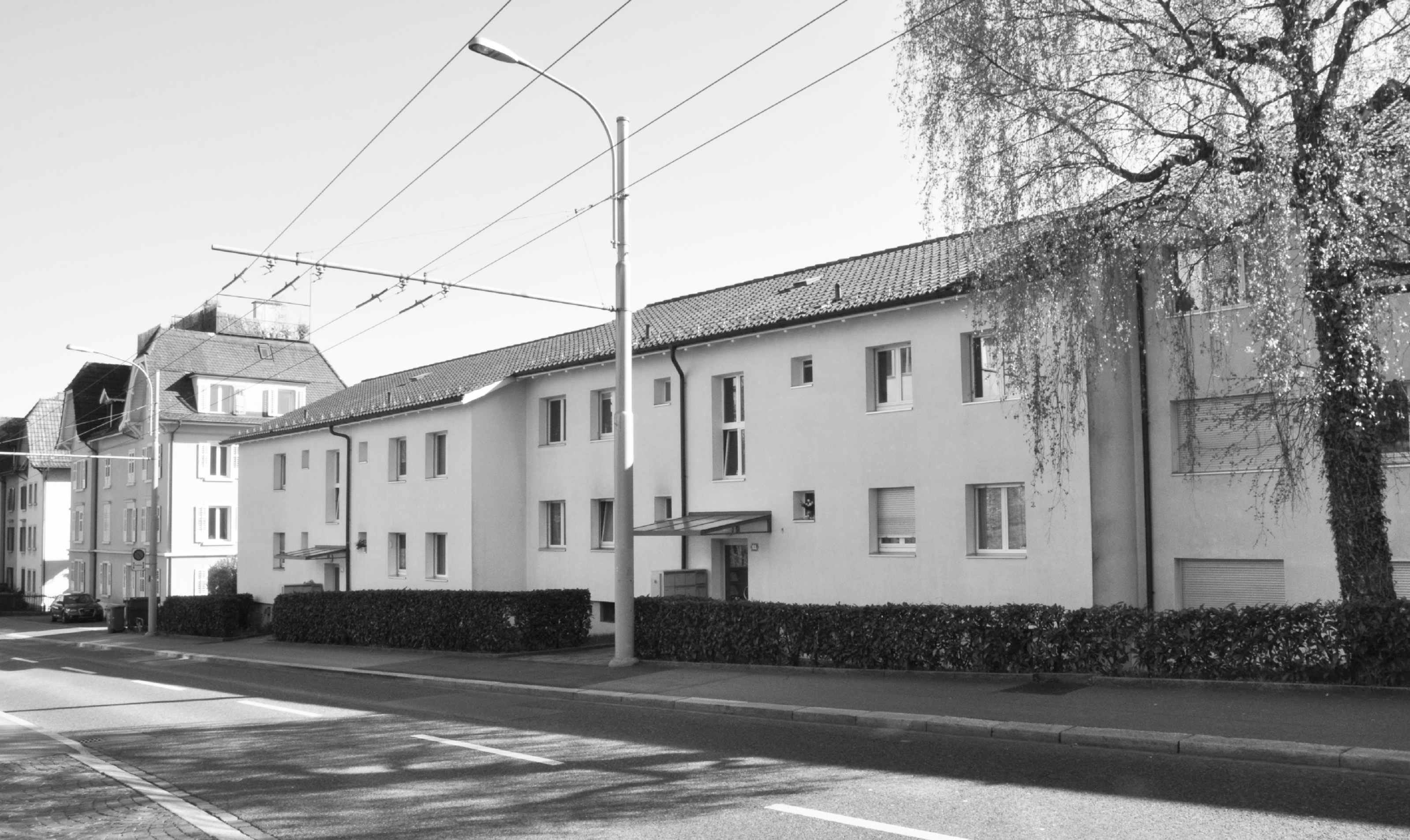
Bestandesbauten Regensdorferstrasse 63-69, 2015. Der Entscheid für einen Ersatzneubau war naheliegend - die statische Ertüchtigung der fragilen Nachkriegsarchitektur hätte in keinem sinnvollen Verhältnis zum gewünschten zeitgemässen Wohnen gestanden.
