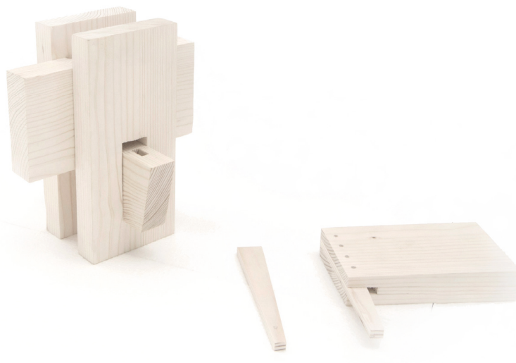
Längsträger mit dem Verbindungskeil als Auflager
