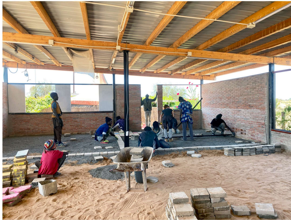
Bodenbelag in der Werkstatt | 1
