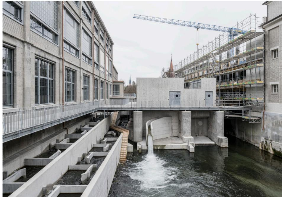
Auch das neue Wasserkraftwerk stammt aus der Feder von Boltshauser Architekten. Es soll 50 Prozent des auf dem Areal benötigten Stroms liefern. Für Fische und Biber wurden Treppen eingefügt.
