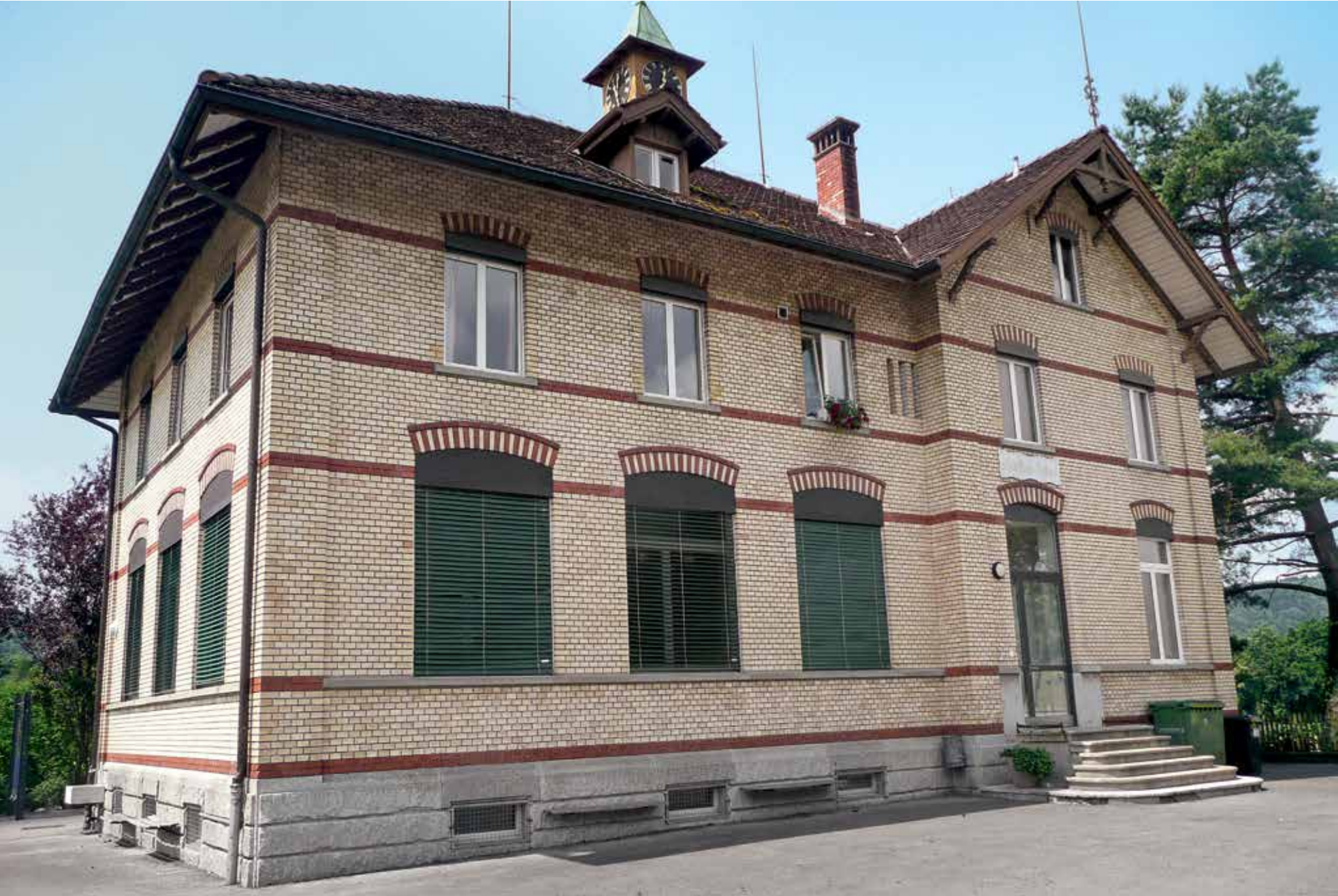
Schulhaus Teufen – Anfang Juli vor der Sanierung
