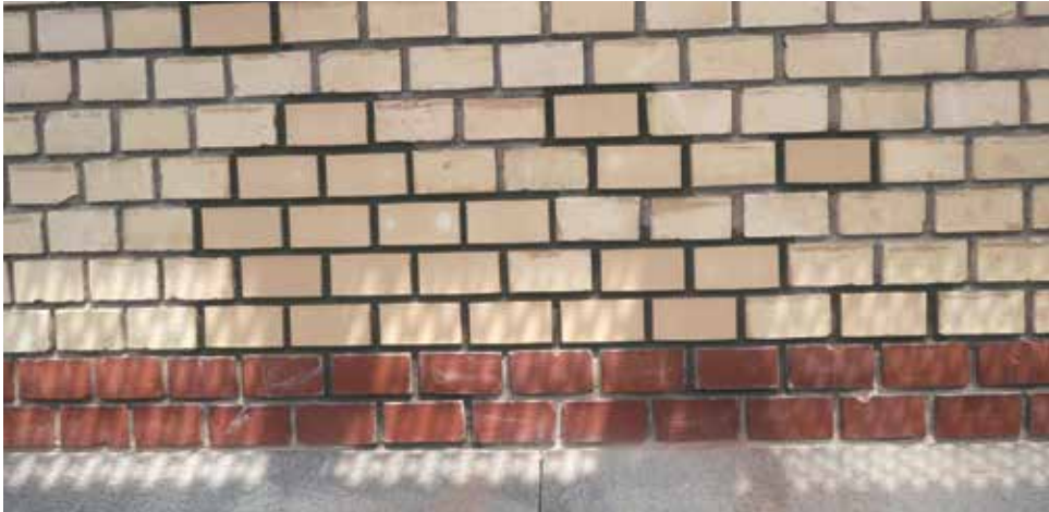
Sauber sanierte Fläche mit roten und weissen Steinen (VHLZ 25/12/6 mp)
