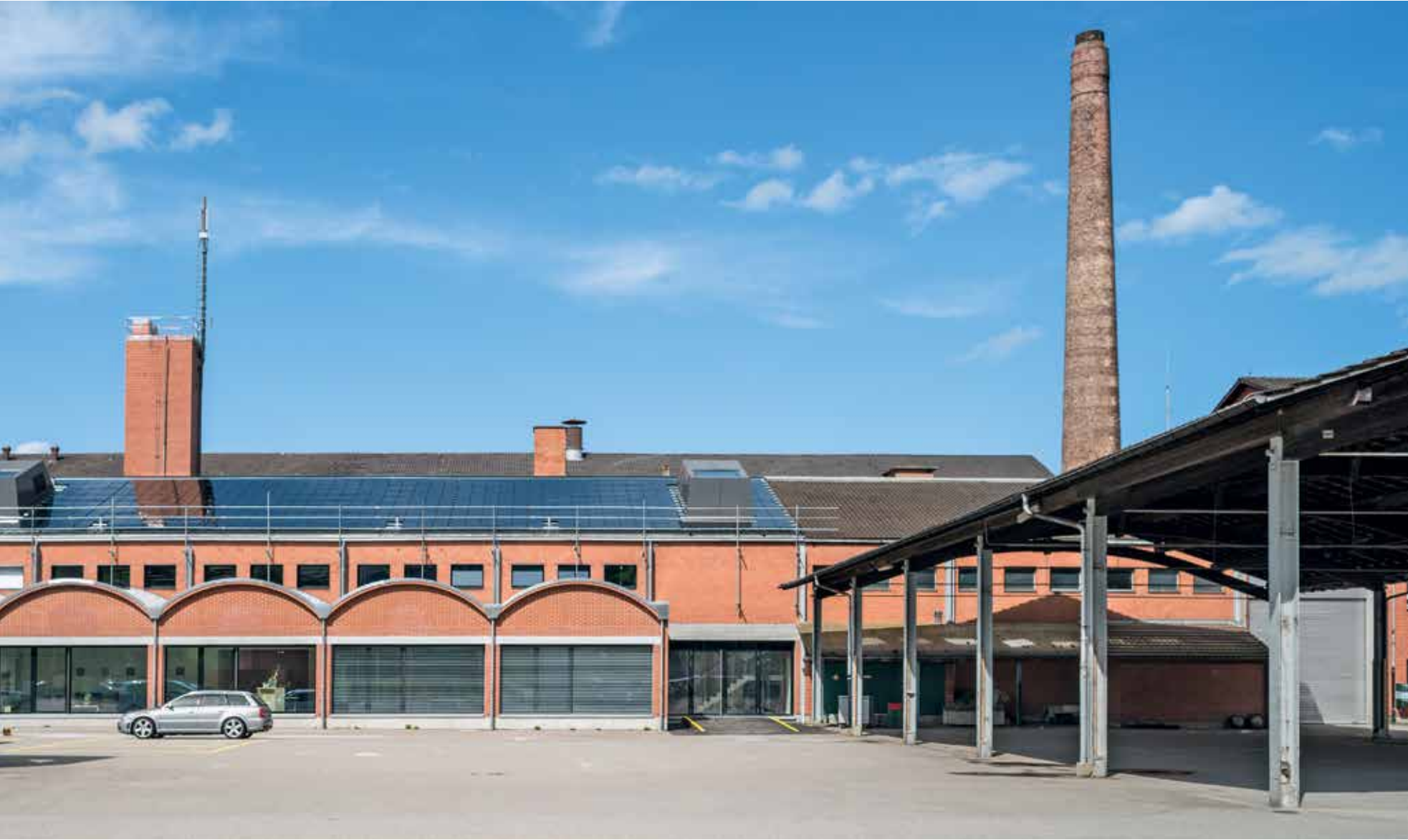
Ofenhalle des ehemaligen Dachziegelwerkes in Pfungen
