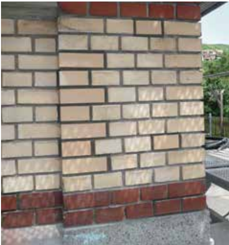
Sauber sanierte Ecklisene, Mörtelfugen 15 mm ausgekratzt
