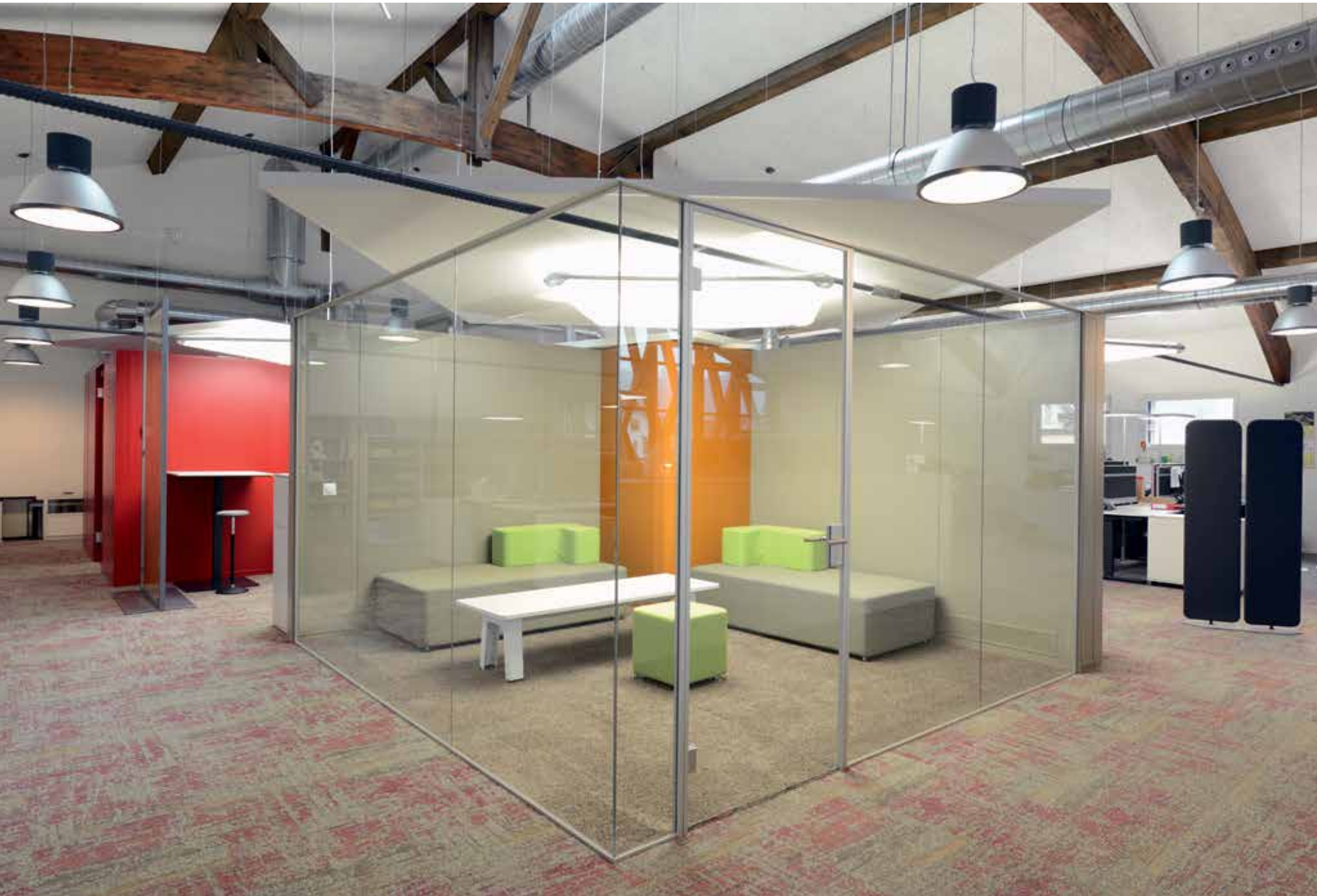
kelux G40 Einfachverglasung 10 mm ESG
