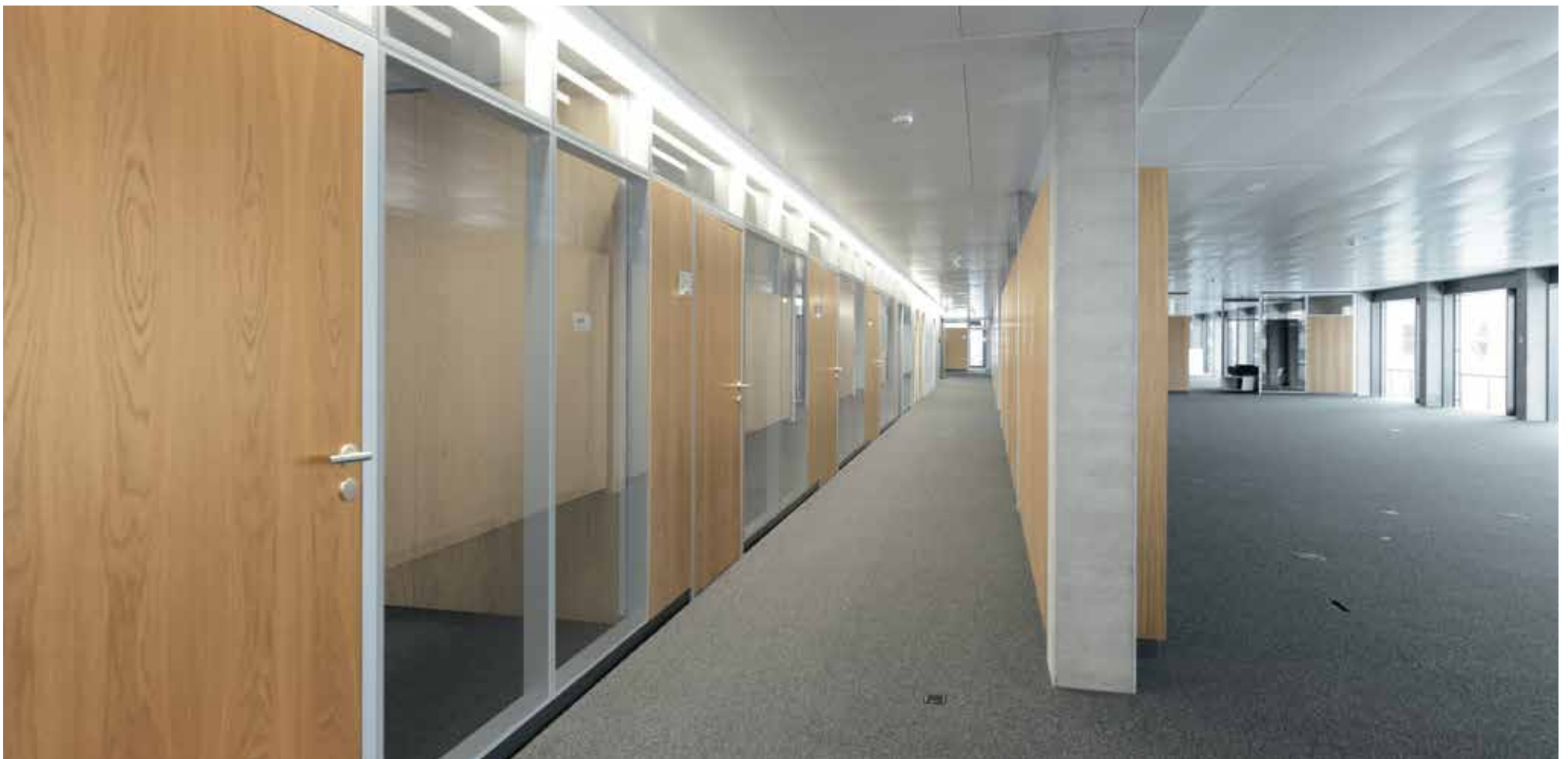
Flurwand, fecostruct Structural-Glazing mit eichenfurnierten Türen
