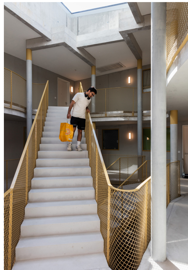
Treppenhaus Haus E | Cage d'escalier maison E
