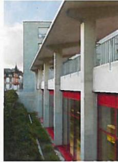
Die aussen liegenden Stützen der Turn- und Schwimmhalle waren bisher der Gestaltung vorbehalten und wurden während der Sanierung in das statische Konzept integriert.
