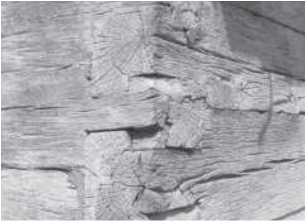
Abb. 47 Eckverkämmung Blockbau
