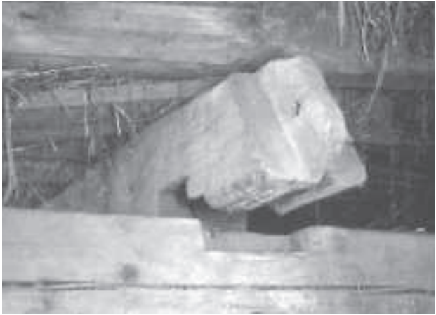
Abb. 46 geöffnete Verkämmung
