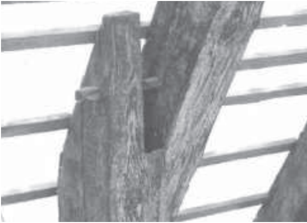
Abb. 49 Blattaufnagelung mit Brust
