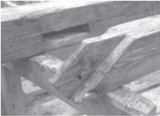
Abb. 44 Anschlussholz mit Zapfen, Gegenholz mit Zapfenloch
