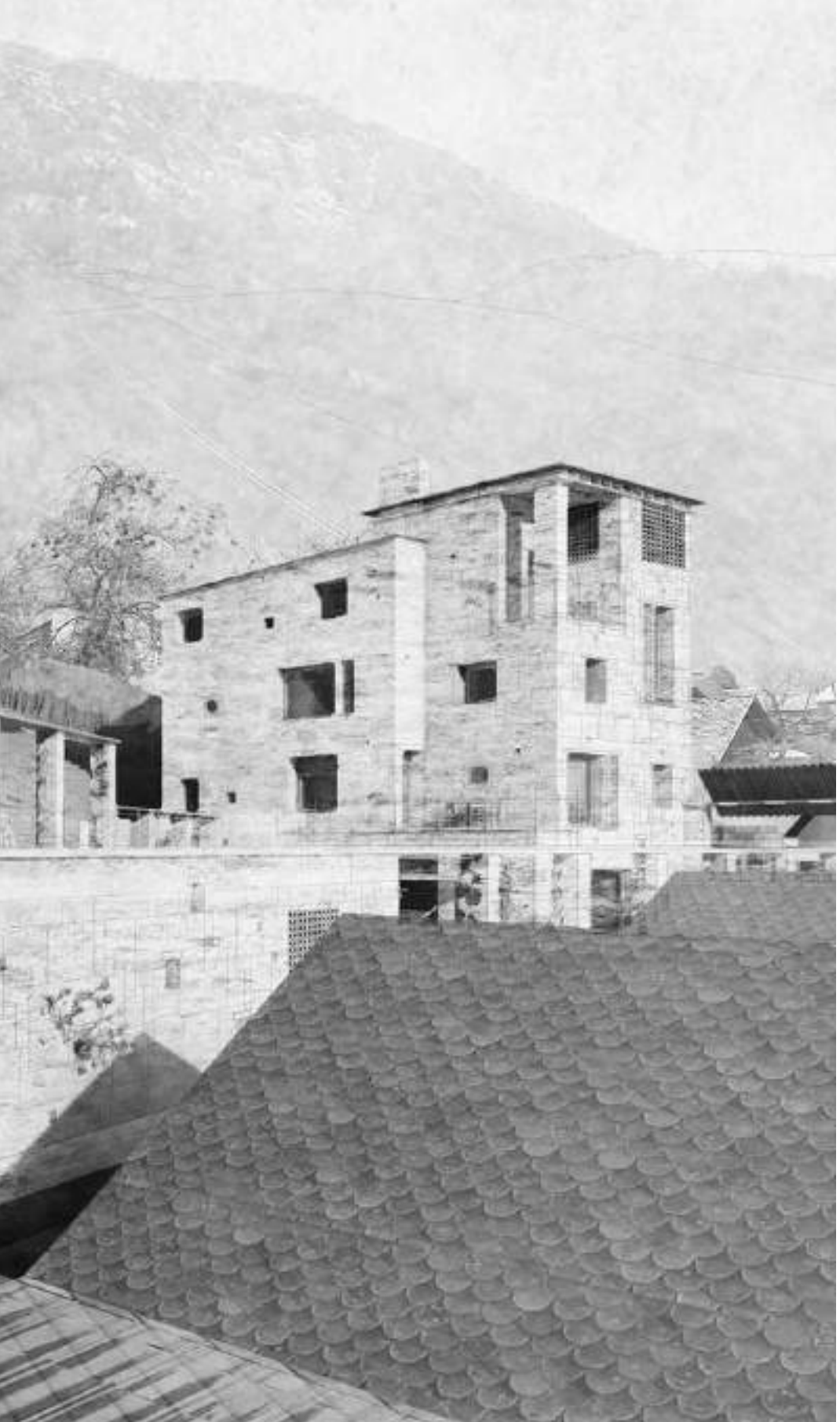
Abb. 5 Mit versetzten Fensteröffnungen, unterschiedlichen Fenstergrössen und einer gewissen spielerischen Herannahungsweise kann auch eine Fassade im Bestand gestaltet werden. Der Bestand verfügt über nur wenige Fenster, die aufgrund der Höhenverhältnisse ohnehin nicht nutzbar gewesen sind. Weinberg | Ennenda | Nicht gebaut Lando Rossmaler
