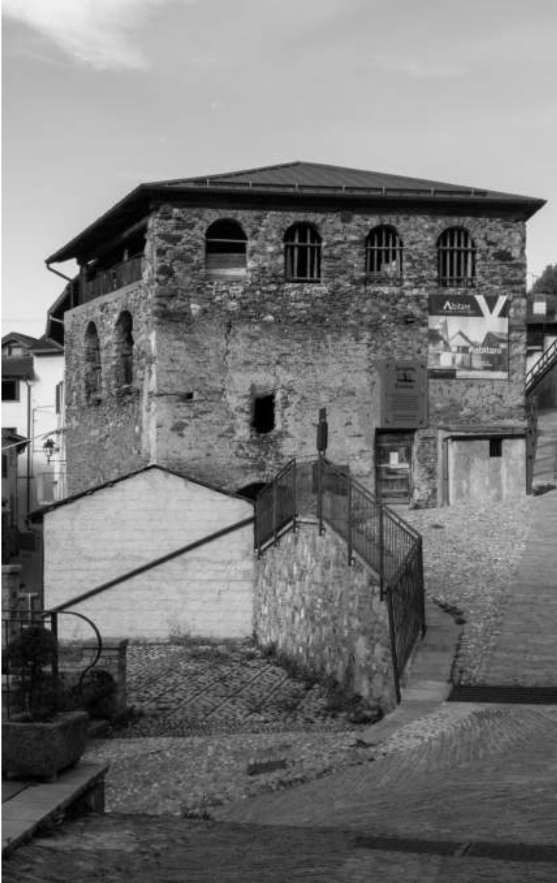
Abb. 1 Der Bestand am westlichen Dorfrand zeichnet sich durch verschiedene, markante Merkmale aus: Ein Bruchsteinmauerwerk , ein Risalit , ablesbare historische Ergänzungen . Die Dachkonstruktion ist zwar alt, aber keineswegs historisch. Dies, da Ausbrüche am Bruchstein darauf hindeuten, dass ursprünglich eine andere Konstruktion auf der Haus' aufgelegt gewesen sein muss. Interessant sind auch die Fensteröffnungen. Können diese sinnvoll weitergenutzt werden? Foto Marco Oertle
