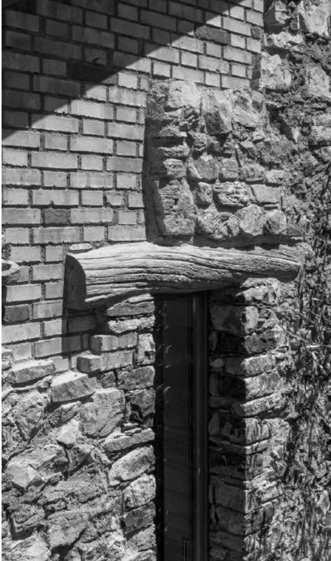
Abb. 2 Mit Backstein als zeitgenössisches Gegenstück zum Bruchsteinmauerwerk kann ein bestehendes Gemäuer präzise und plastisch ergänzt werden. Das bestehende Mauerwerk wird dabei so fortgeführt, dass es wohl ineinander gefügt, jedoch nicht voneinander abhängig wird. Der Backstein ist nur ergänzend. Ristrutturazione rustico aldesago | Lugano Enrico Sassi Architetto
