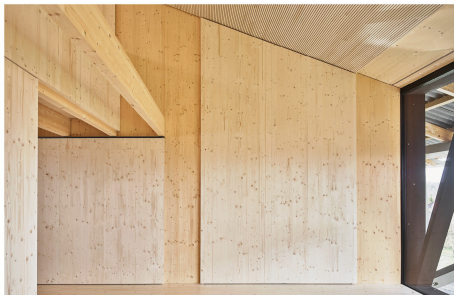
Hausteil C, 1. Obergeschoss
