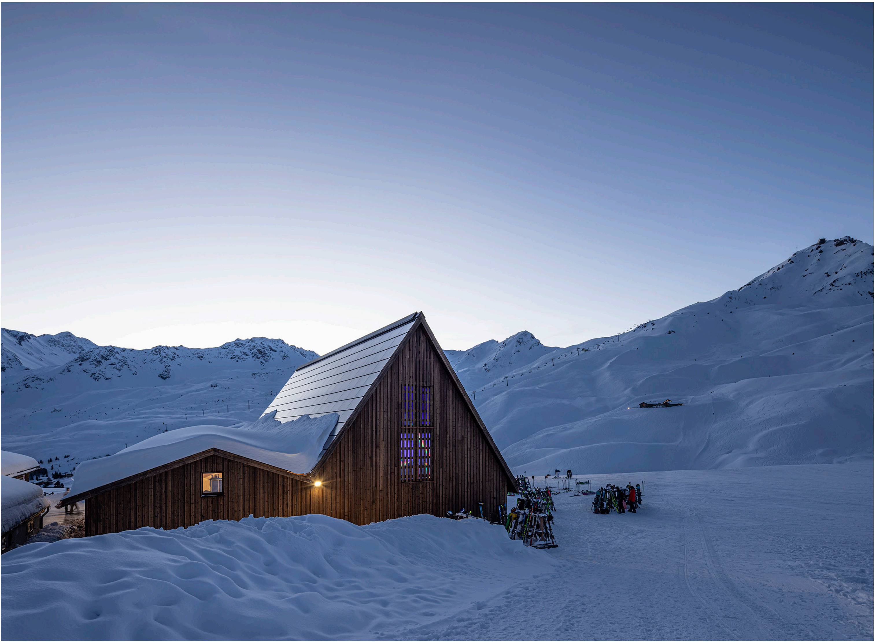
Neubau KuhBar, Arosa (2'000 m.ü.M)
