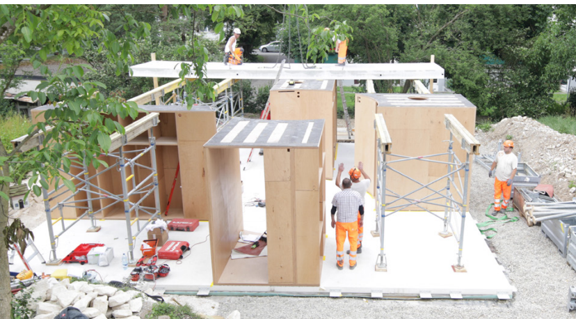
Versetzen der Dachelemente aus Beton
