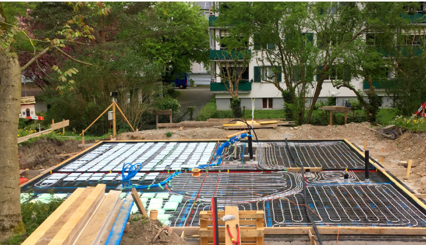
Verlegen der PCM Elemente aus Salz und Wachs
