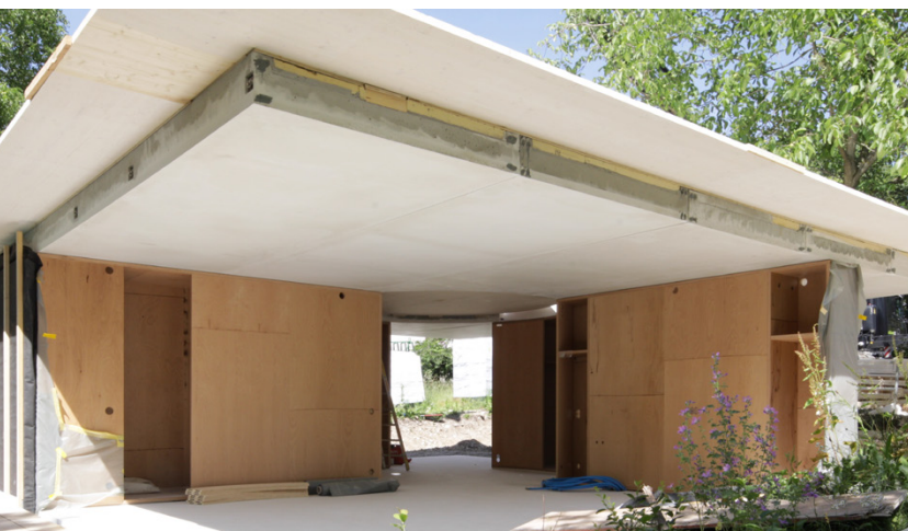
Fertig aufgerichtete Gebäudestruktur
